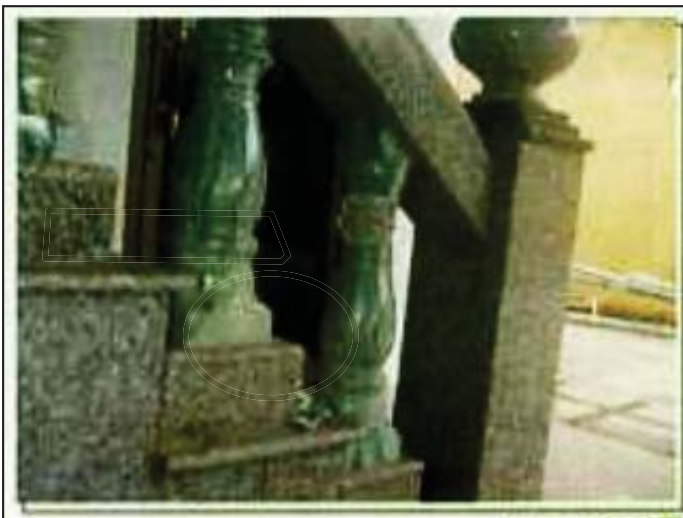
เสาราวบันไดเซรามิกมีการแตกร้าว ที่วัดโตนดหลวง ตำบลเมืองเก่า อำเภอชะอำ จังหวัดเพชรบุรี
