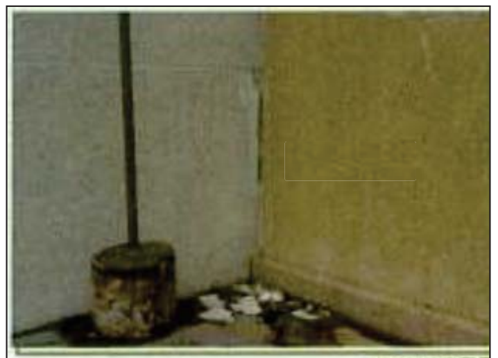
ผนังหินขัดมีการกระเทาะหลุดออกมาจากผนังเดิม ที่วัดโตนดหลวง ตำบลเมืองเก่า อำเภอชะอำ จังหวัดเพชรบุรี
